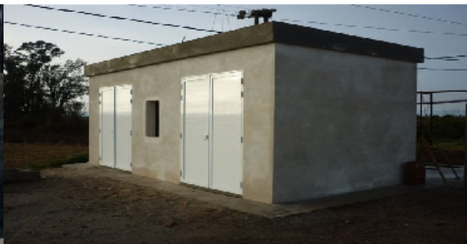
Construcción cabina media tensión
